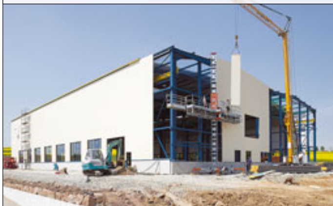
Montage der Giebelverkleidung durch zwei Monteure in Verbindung mit funkgesteuertem Schnellbaukran und Mastkletterbühne FRSM 1500 von Fraco
