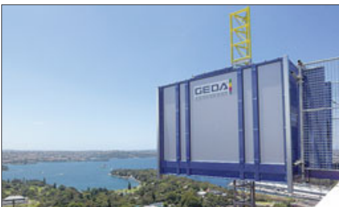
Der Multilift von Geda, vor anderthalb Jahren als so genanntes Mittelklassegerät eingeführt, kommt selbst „Down Under“ zum Einsatz: als P12 in Sydney, Australien, mit einer Höhe von 135 Meter
