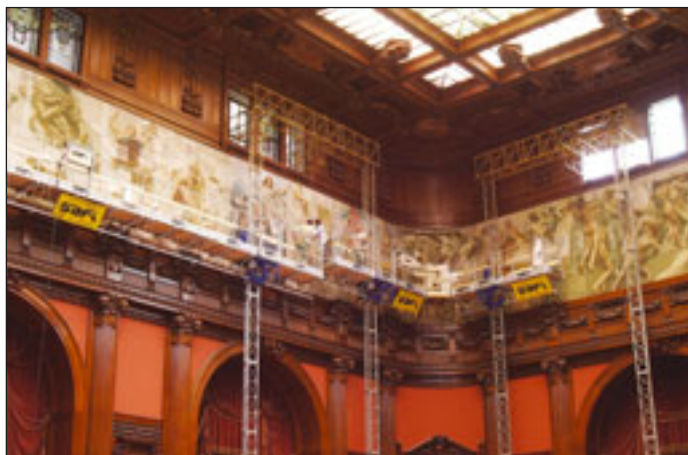
Safi-Mastklettertechnik im Einsatz am Montecitorio in Rom, dem Sitz der Abgeordnetenversammlung des italienischen Parlaments
