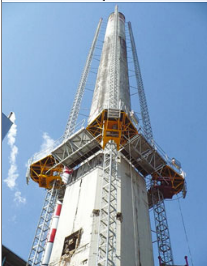
Saeclimber aus Madrid im Sanierungseinsatz in der Industrie
