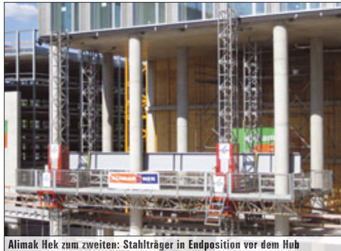
Alimak Hek zum zweiten: Stahlträger in Endposition vor dem Hub
