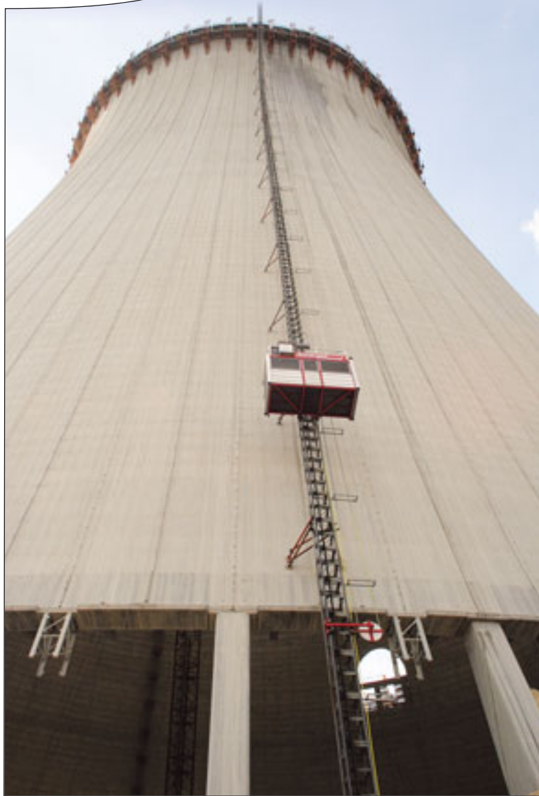
Doppelt gigantisch: Steinweg-Böckers Giant-Lift am 183 Meter hohen Kühlturm
