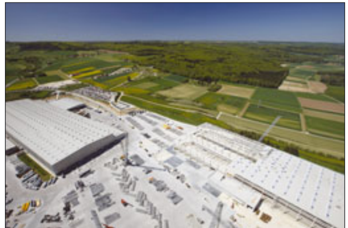
Ein neues Montagewerk für Raupenkrane entsteht derzeit in Ebingen
