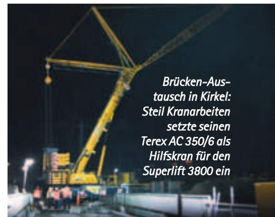
*Brücken-Austausch in Kirkel: Steil Kranarbeiten setzte seinen Terex AC 350/6 als Hilfskran für den Superlift 3800 ein*
