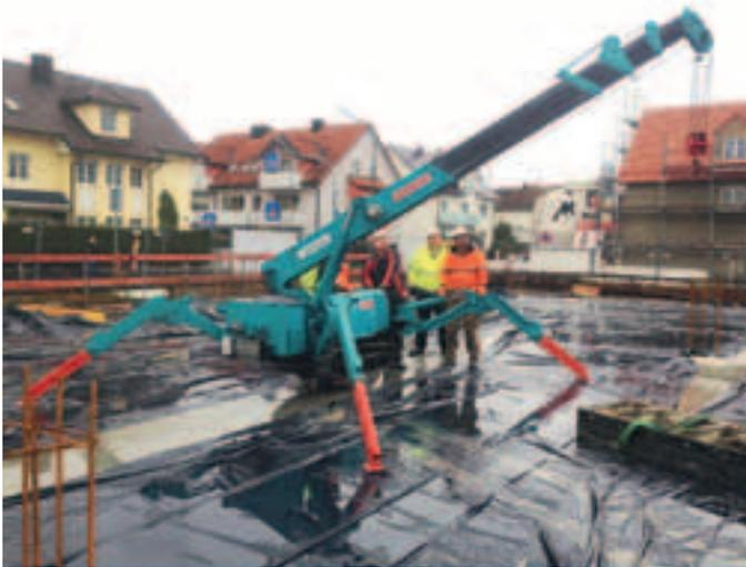
» Eine Stromtrasse war im Weg, also kam nur ein Turmdrehkran in Kombination mit einem Maeda-Minikran MC 285 CRM sowie einem Merlo-Teleskoplader Roto 38.16 in Frage für den Einsatz auf einer Baustelle in Karlsfeld bei Dachau. Bilfinger Hochbau und Cramo entwickelten dieses Alternativkonzept. Der Minikran war im Zwischengeschoss für die notwendigen Hübe zuständig.
