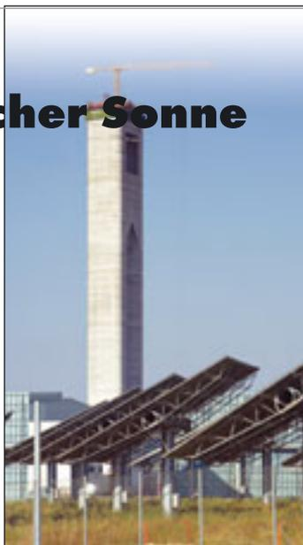
des Baufortschritts des Solarturms in die Höhe und erreichte in nur zwei Monaten eine Hubhöhe von über 165 Metern. Die Demontage wird nach Abschluss der Arbeiten mit Hilfe eines Hubschraubers durchgeführt.
