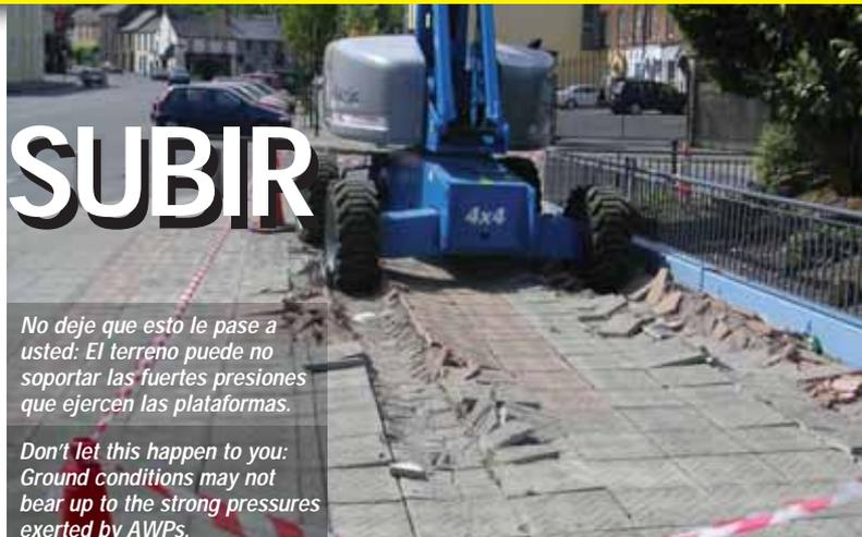
*No deje que esto le pase a usted: El terreno puede no soportar las fuertes presiones que ejercen las plataformas.*
